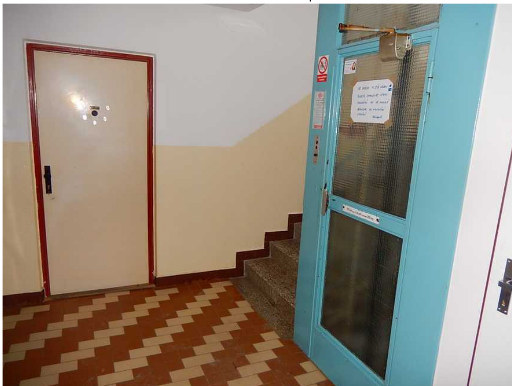
schodiště s osobním výtahem v BD č.p. 588
